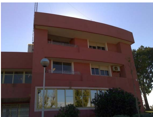
Imagen 2. Fachada fábrica de ladrillo + mortero monocapa- Cubierta plana no transitable
