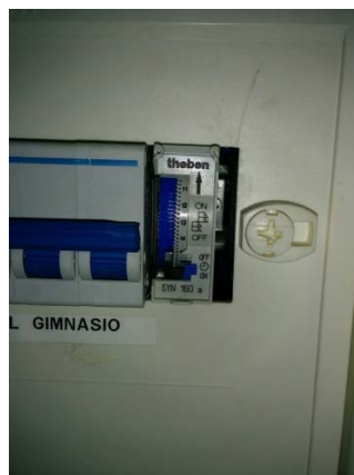
Imagen 9. Reloj convencional para alumbrado exterior
