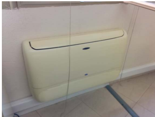
Imagen 13. Unidad interior tipo Split de suelo
